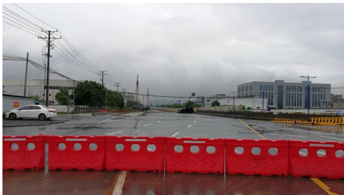
金桥北路综合管廊终点
