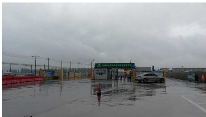
金桥北路综合管廊起点
