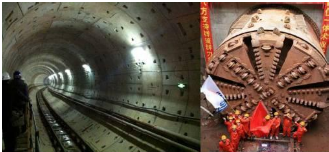
图 11-1 地下区间盾构法施工照片
