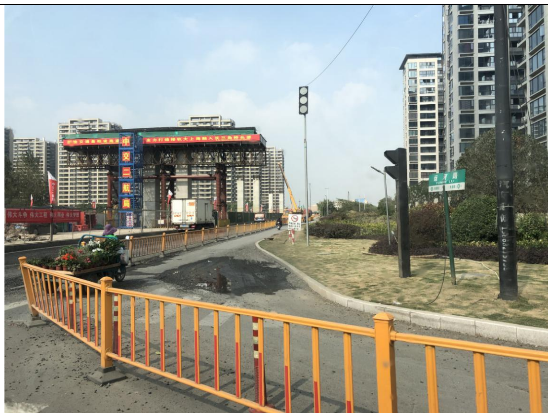
104 国道与疏港公路交叉口拟建电缆线路现状照片
