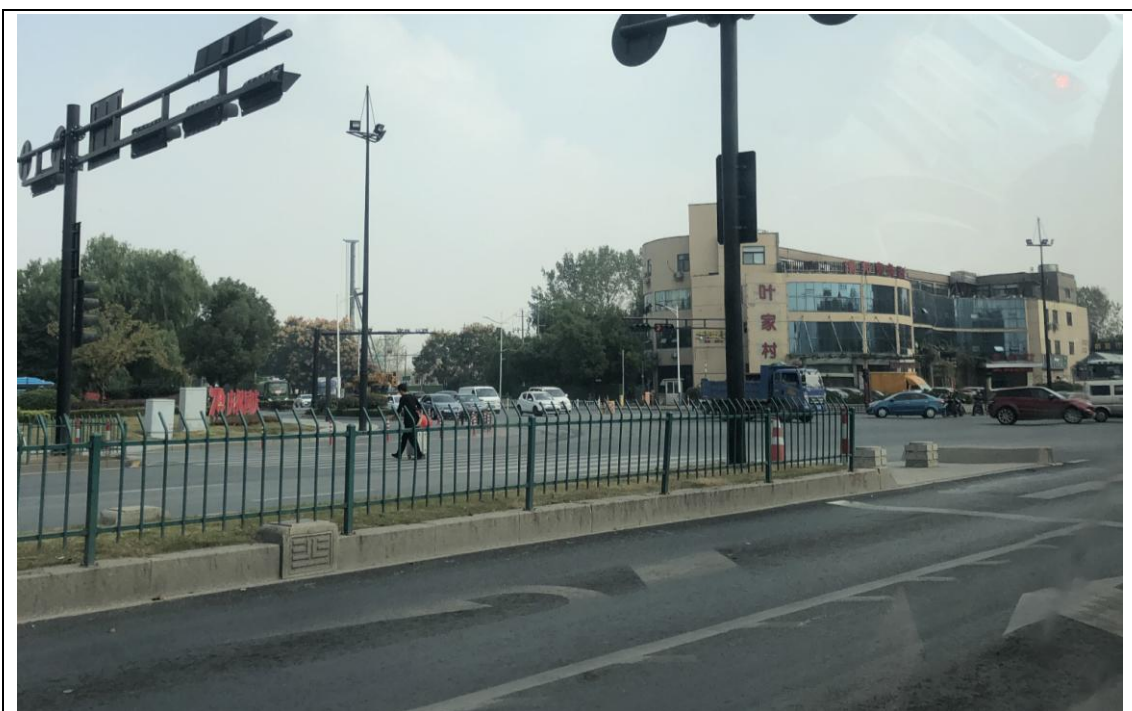
天阳楼西北侧交叉路口拟建电缆线路现状照片
