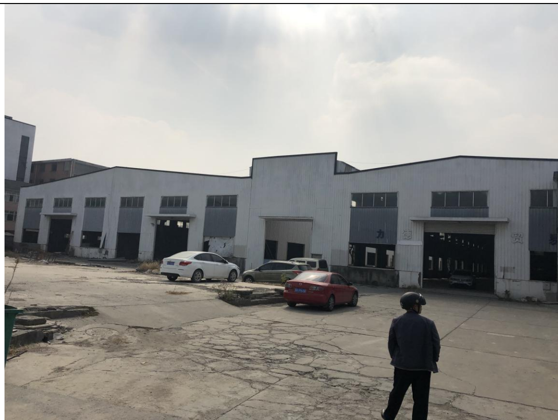
莫干山路 1903 号（拟拆除）
