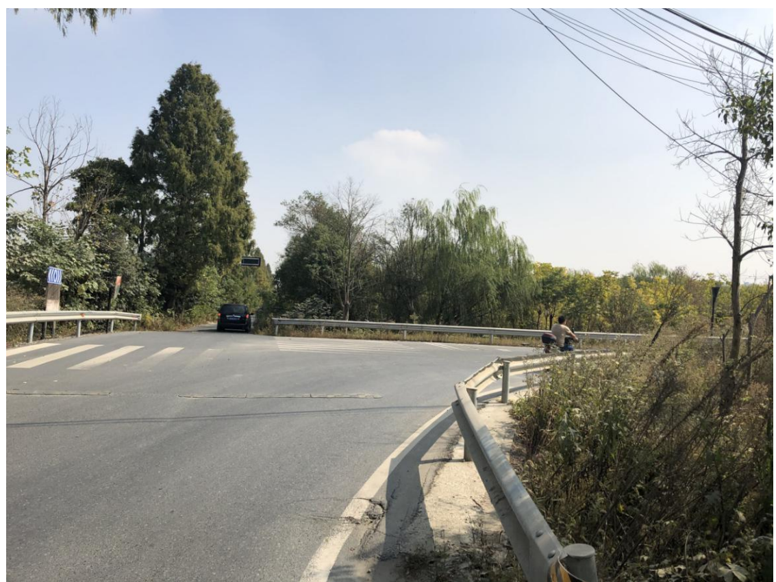
爱新汽车服务有限公司西北侧拟建电缆线路现状照片
