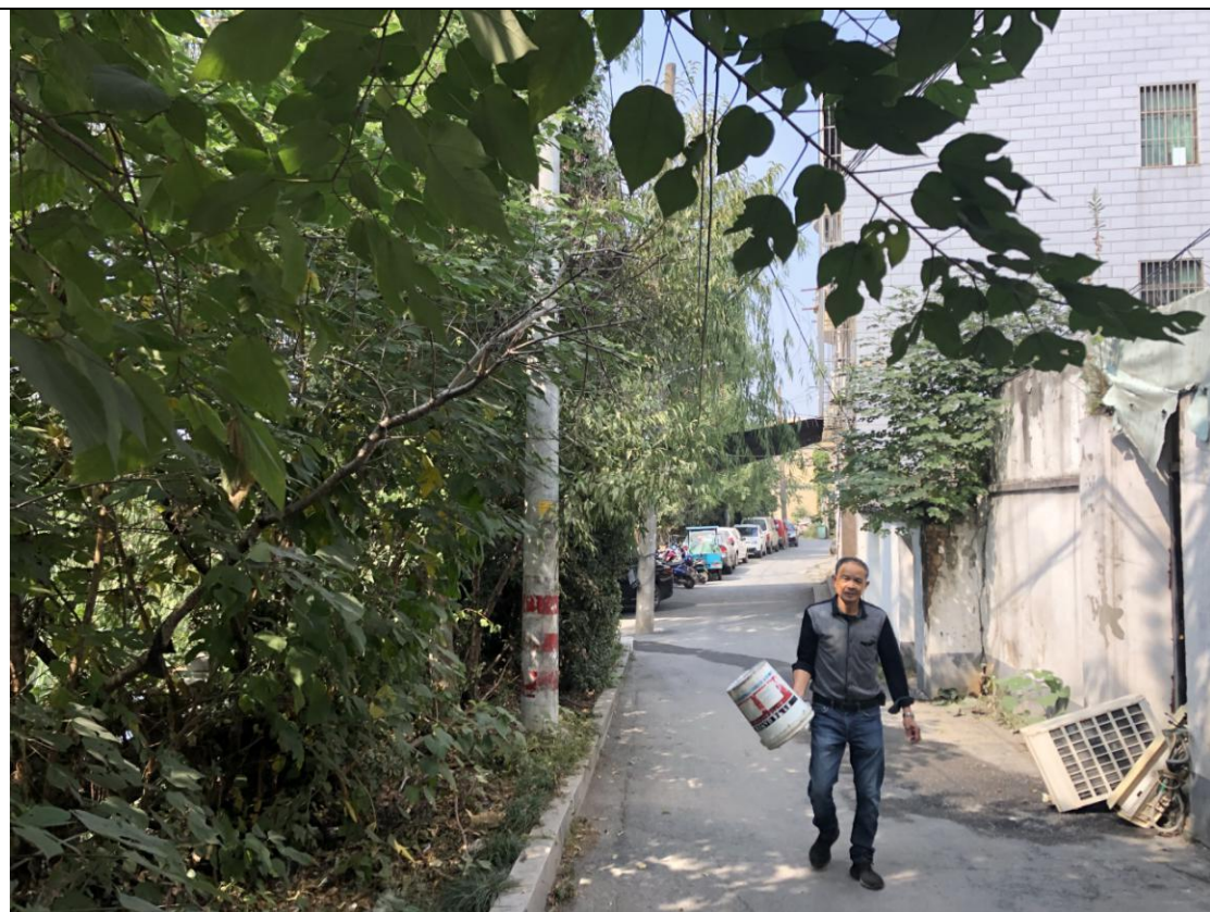
西塘河东侧拟建电缆线路现状照片
