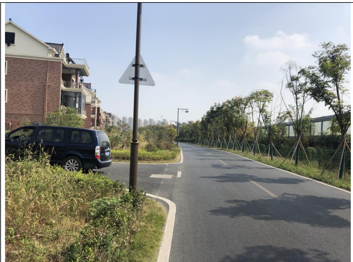
S14 杭长高速北侧拟建电缆线路现状照片
