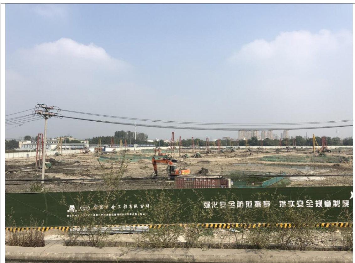
古墩路东北侧拟建电缆线路现状照片
