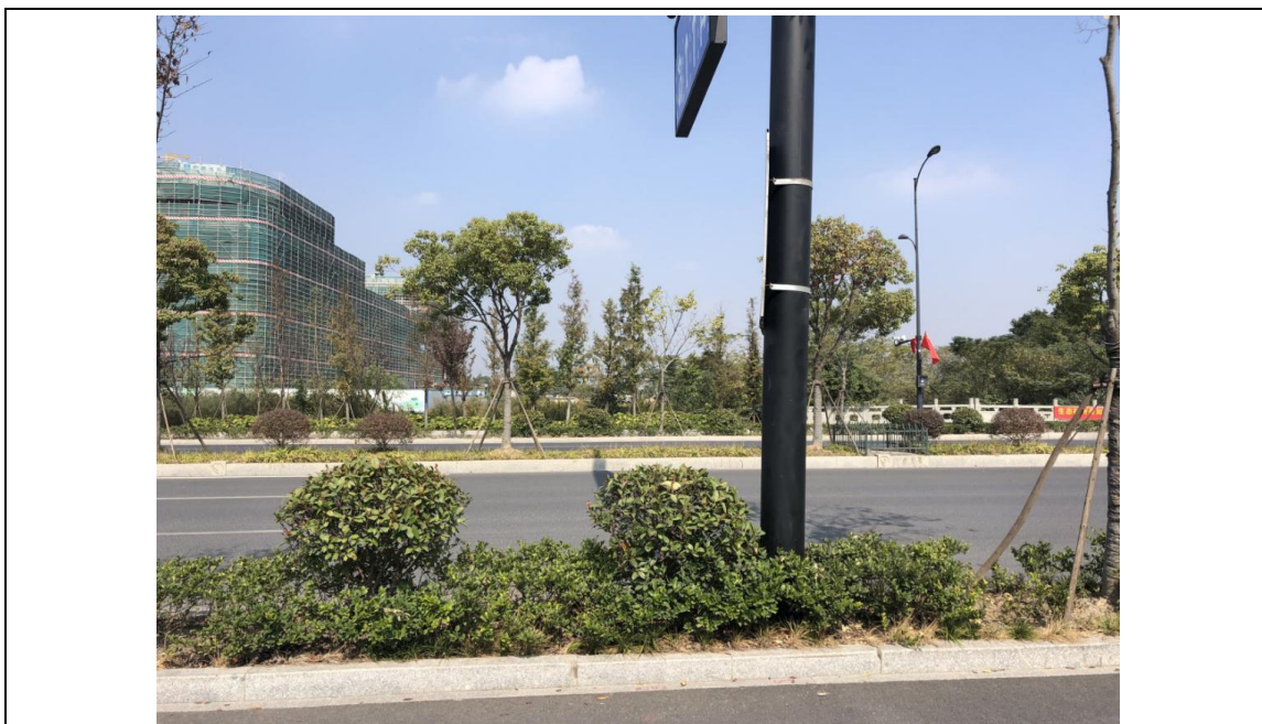
灯彩街拟建电缆线路现状照片
