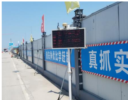
施工围挡及环境监测系统
