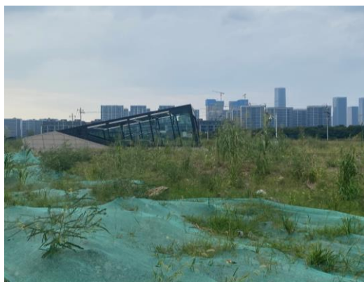
施工占地绿化（绿汀路站施工场地）
