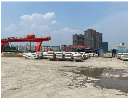
施工场地硬化
