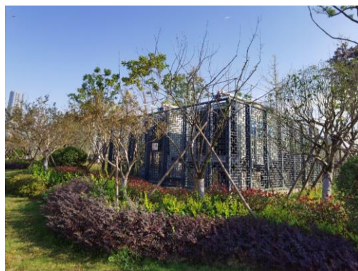
葛巷站冷却塔
