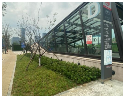
施工占地恢复（葛巷站施工场地）
