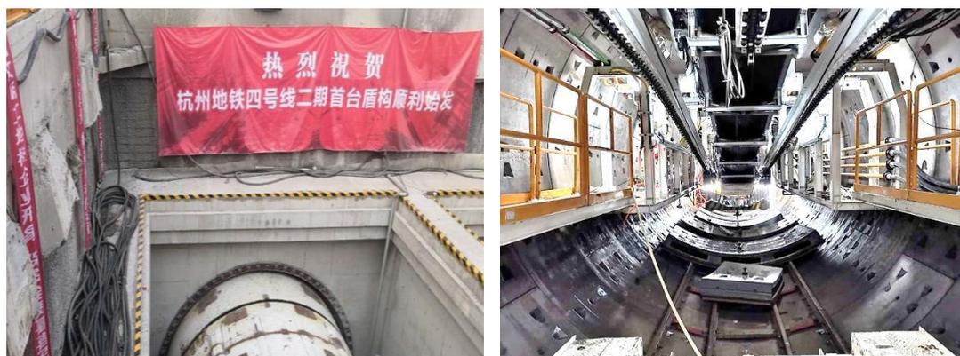
图 2.1—6 盾构法施工现场照片
