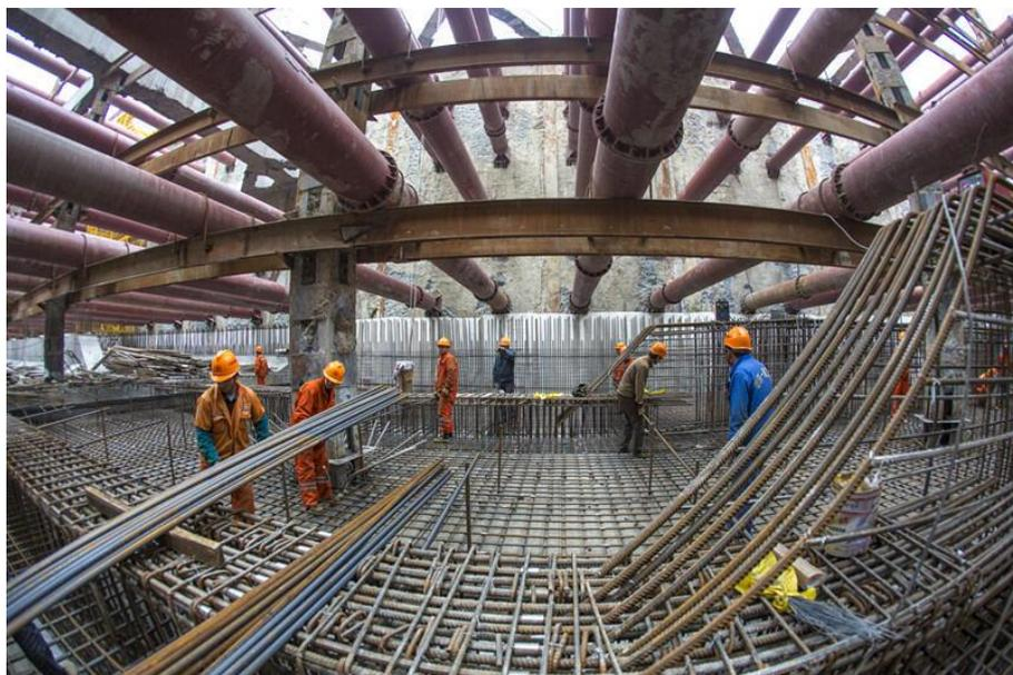
图 2.1-5 明挖车站施工现场照片
