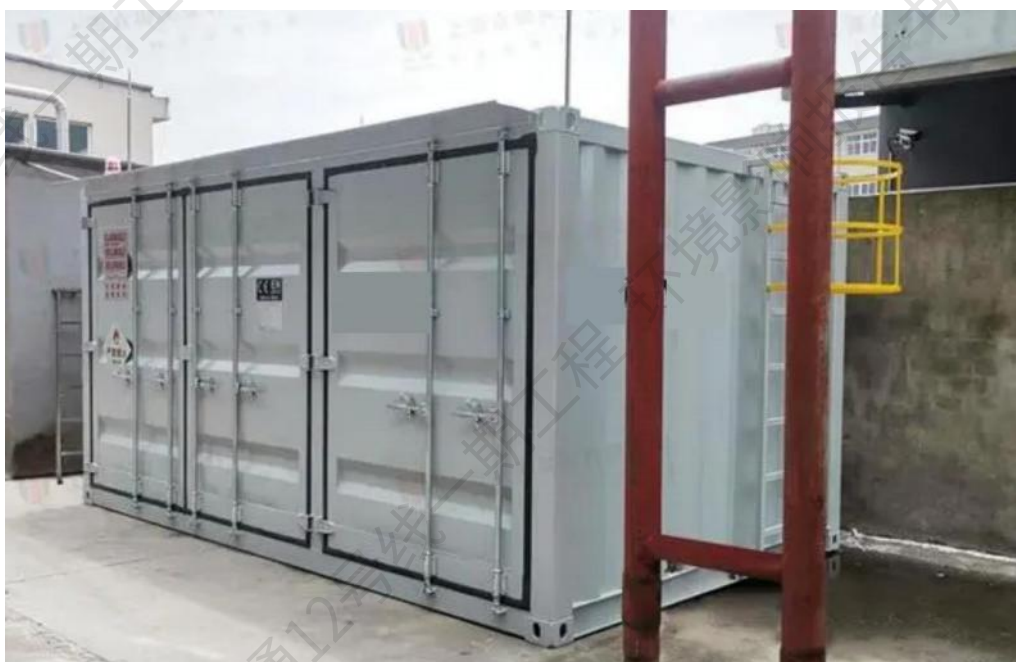
图 11.8-1 可移动式危废暂存间典型照片
