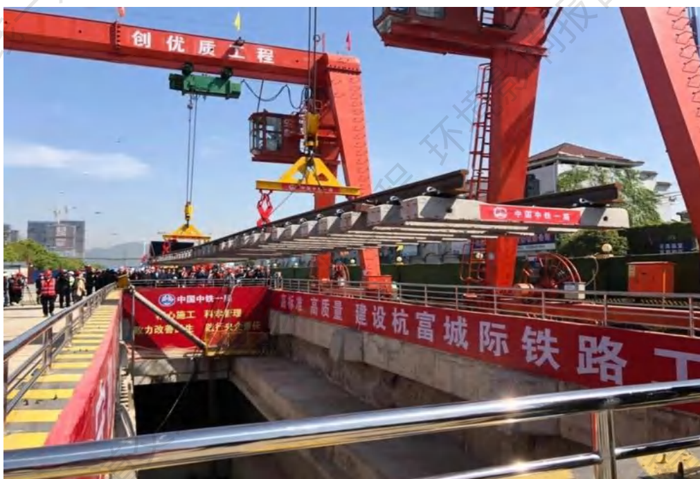
图 2.1-8 杭州市地铁典型施工场地布置图及类似项目铺轨示意照片
