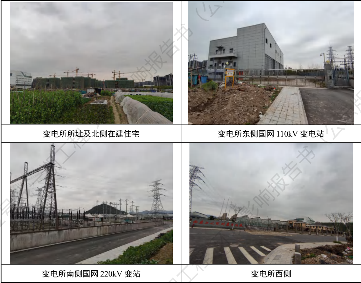
图 10.2-3 110kV 铁之江主变电所周边环境现状照片
